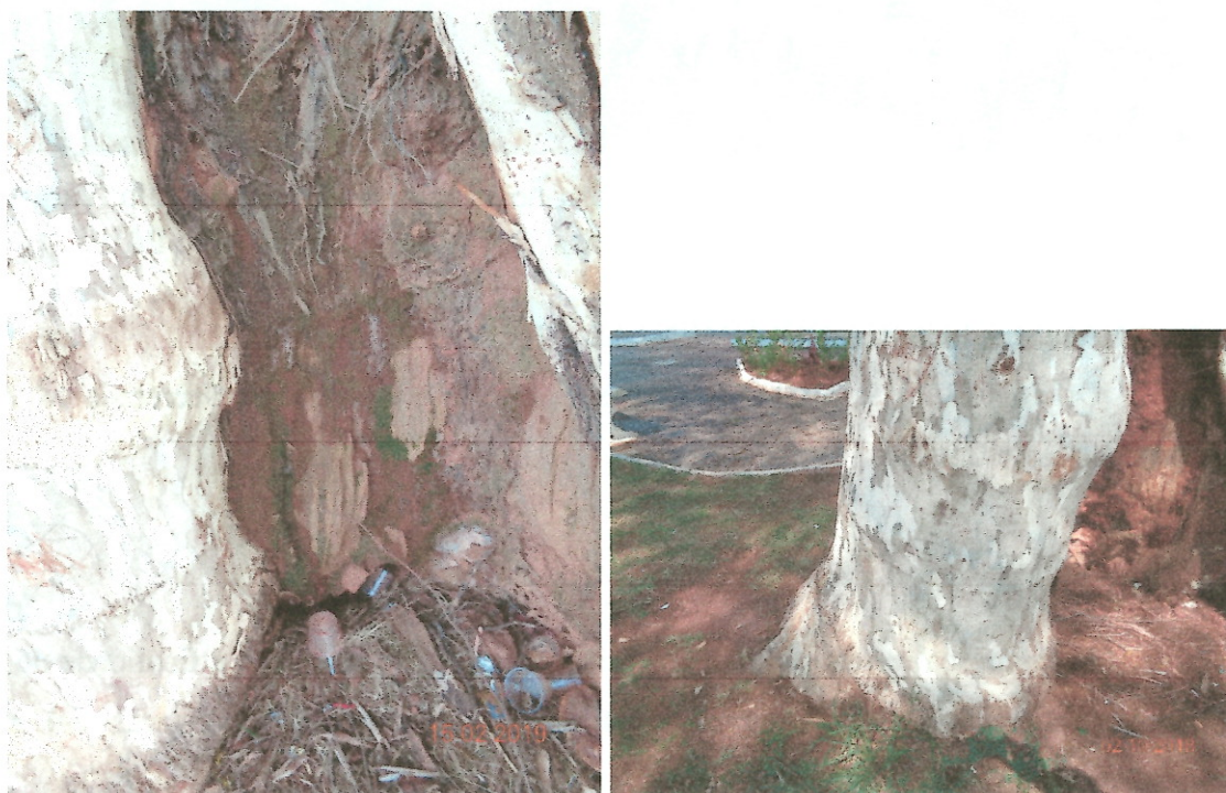
Figura 2. Presença de cupins e formigas constatada nas duas últimas vistorias, Centro, Catalão, GO. Autor: Resende Jr.
